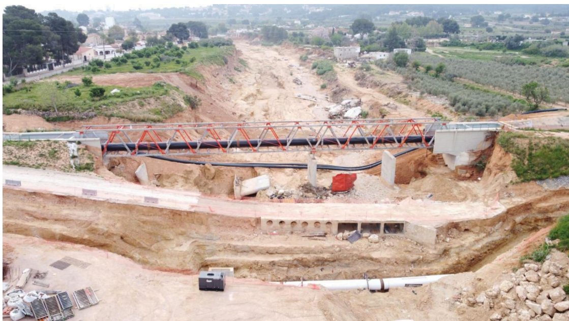
Barranco de La Horteta tras las obras de emergencia. CHJ
